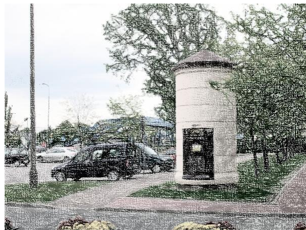
Рисунок 12 Подстанция наземного типа
